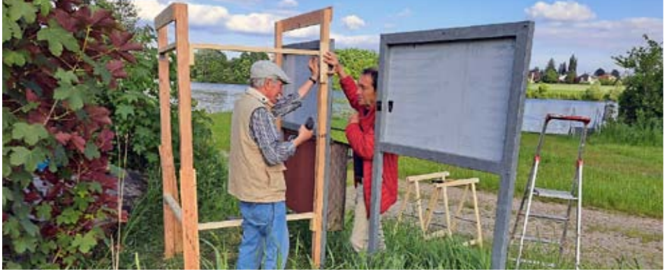
Bau eines Schuppens für Sensen & Co.: Insel Mariaort
